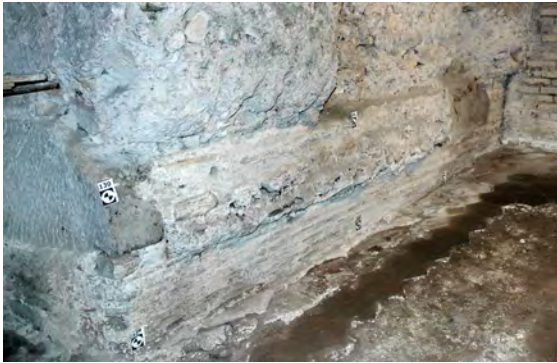
FIG. 25. PARAPETTO DEL VANO M, DA NORD; EVIDENTI I DUE BLOCCHI DI PEPERINO, PROBABILE SOSTEGNO DI COLONNE. AI PIEDI DEL MURO IL PIANO IN BIPEDALI.
