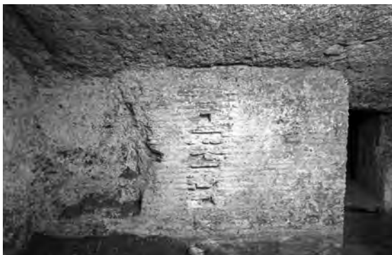
FIG. 27. VANO L, PARETE OVEST: PARTE INFERIORE DEL FINESTRONE, DA EST; VISIBILI IN ALTO I BLOCCHI IN PEPERINO RIUTILIZZATI PER LA CHIUSURA DELLA PARETE MODERNA.
