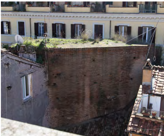
FIG. 16. CIAMBELLA, IL TAMBURO, DA NORD; VISIBILE IN BASSO UNO DEGLI ARCHI DI SCARICO A PROTEZIONE DELLE NICCHIE.
