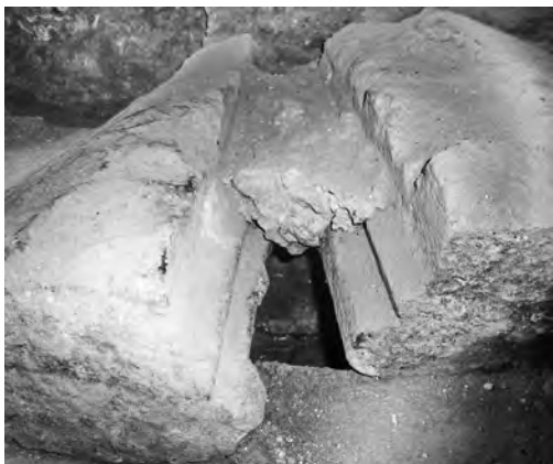
FIG. 33. BLOCCHI IN PEPERINO MODANATI A COPERTURA DI UNA FOGNA OTTOCENTESCA.
