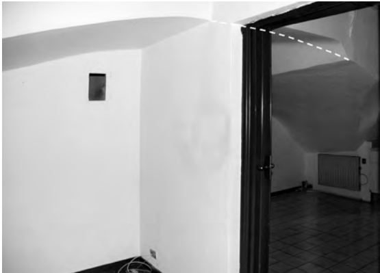
FIG. 14. TESTATA DELL'ARCO NEORD DELLA CIAMBELLA, DA NORD.
