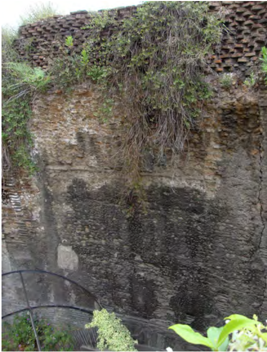
FIGG. 8-9. CIAMBELLA, INTRADOSSO OCCIDENTALE E ORIENTALE; EVIDENTI LE NERVATURE A CASSETTA. IN BASSO LA DOPPIA GHIERA A PROTEZIONE DI UN NICCHIONE INTERNO.
