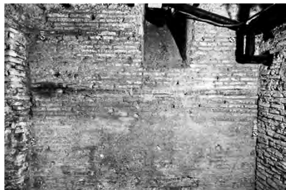
FIG. 39. VANO C, MURO TRAIANEO/ADRIANEI; VISIBILI I FORI DELLE GRAPPE PER IL RIVESTIMENTO MARMOREO.
