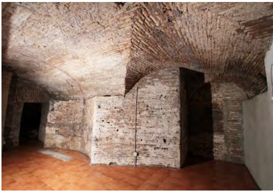
FIG. 15. CIAMBELLA, PARTE DELLA NICCHIA SUD-OVEST (A SN.) E SPALLA DELLA NICCHIA OVEST (A DS.).
