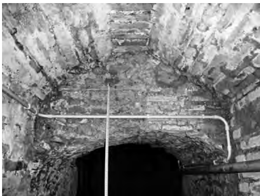
FIG. 40. VANO C, PARETE OVEST; MURO CON TRACCE DI SCALA, DA EST.
