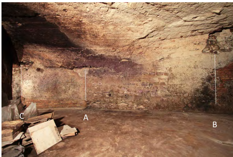
FIG. 12. CIAMBELLA SETTORE NORD-EST; TRA A E B LA NICCHIA 13 TAMPONATA IN ANTICO. IN C IL LIMITE DEL PILASTRO DELL'ACCESSO AL VANO I.
