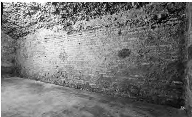
FIG. 41. VANO A, PARETE NORD.
