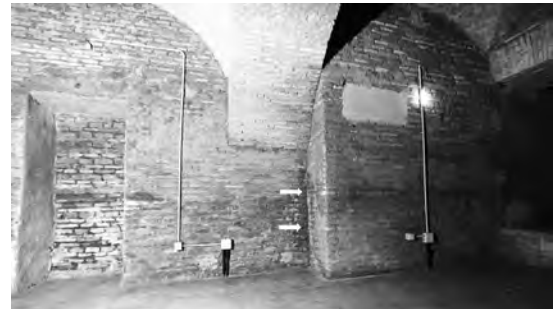
FIG. 45. VANO T, PARETE OVEST; LE FRECCE INDICANO LA SPALLA DELLA NICCHIA A SCARSELLA.
