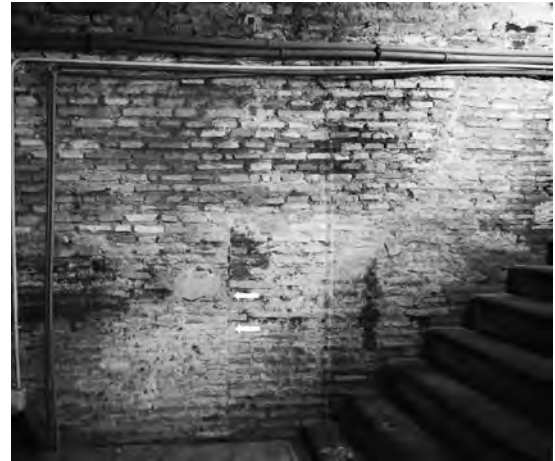
FIG. 43. VANO H; EVIDENTE, A DS., IL MURO RESECATO.
